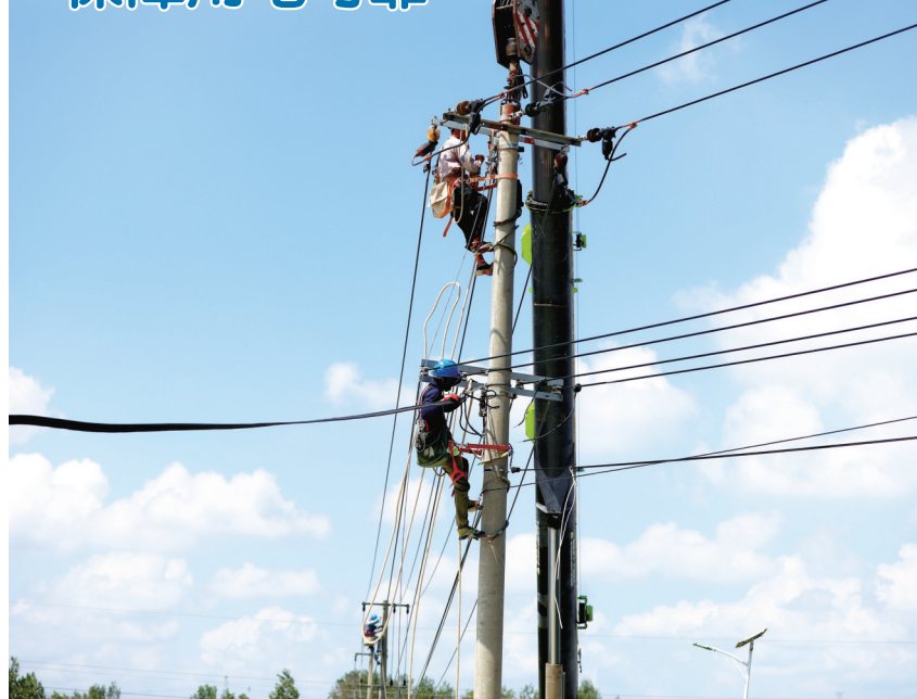
8月28日,国网长丰县供电公司电力人员在110千伏百花变电10千伏镇北06线方岗支线开展线路升级改造工作,消除线路运行隐患的同时,进一步提升片区供电可靠性。
