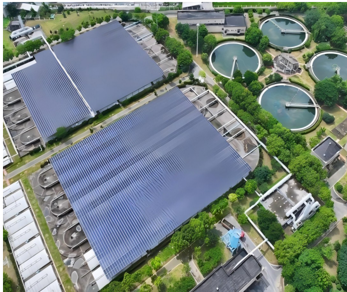
7月22日,航拍的合肥市望塘污水处理厂光伏电站。望塘污水处理厂位于合肥市蜀山区,新建光伏项目利用厂区闲置空间进行建设。
