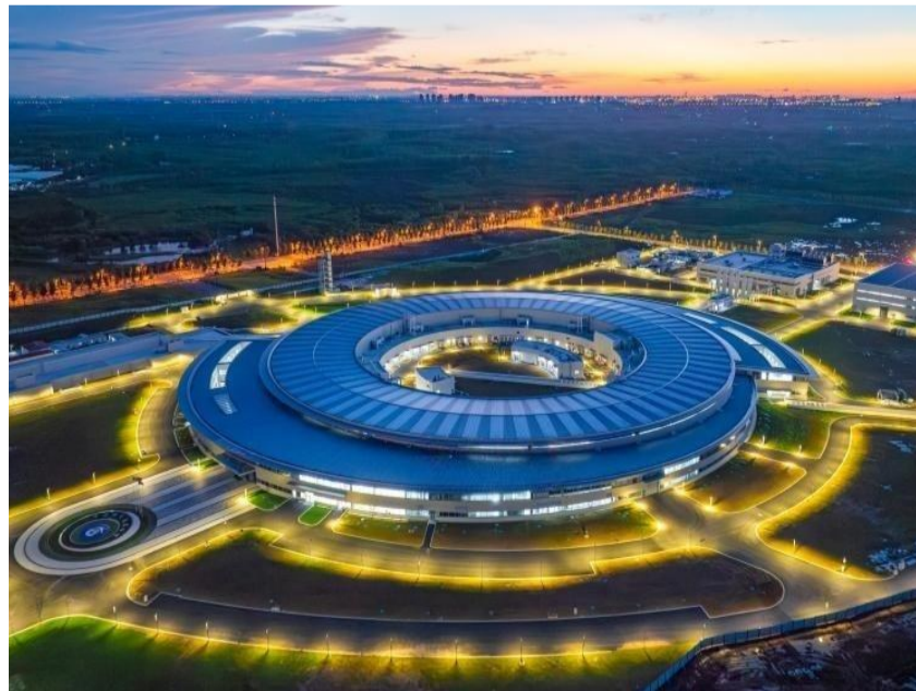
7月5日,航拍的位于安徽省合肥市长丰县岗集镇的合肥先进光源(HALF)园区。近日,合肥先进光源(HALF)园区正式启用,项目建设进入设备全面安装的新阶段。
