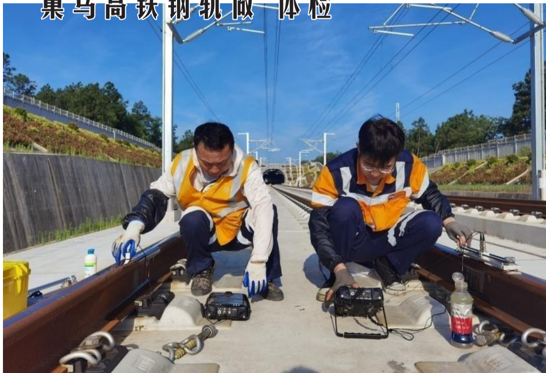
5月16日,国铁上海局合肥高铁基础设施段探伤车间组织30余名技术骨干,对巢马高铁钢轨焊缝进行全面探伤体检,为新线如期开通运营做好准备。 王伟摄
