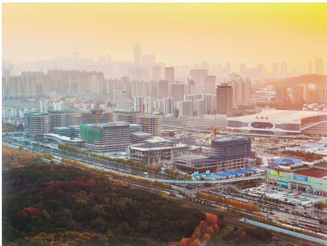
12月2日,安徽省芜湖市镜湖区,芜湖数字经济产业园项目施工现场塔吊林立,一幢幢建筑拔地而起,各作业区上千名施工人员在紧张施工,加快推进工程进度。 梁浩 摄
