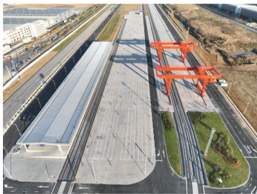
新建合肥派河港铁路物流基地工程。
