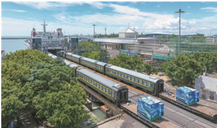
首批移动储能电站在粤海铁路投入使用。
