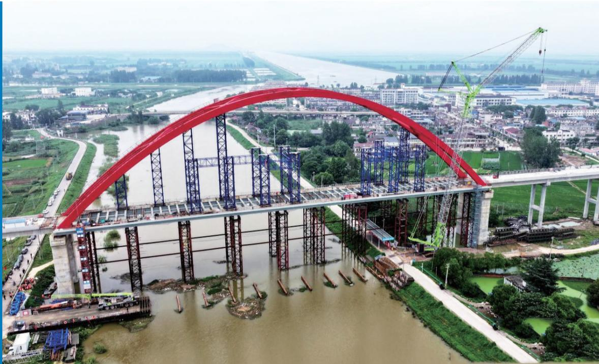
7月16日,在合肥市庐江县白湖镇兆河段,引江济淮白湖大桥正加紧施工中。白湖大桥项目路线全长4.9公里,其中主桥长170米,宽20.6米,结构形式为下承式钢箱系杆拱桥,拱桥最高处距桥面41.8米。目前主桥的主体结构施工已经全部完成,计划8月份全线完工。
