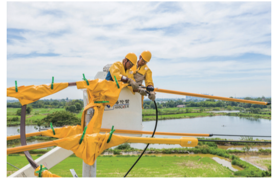
图为该公司开展不停电作业。
