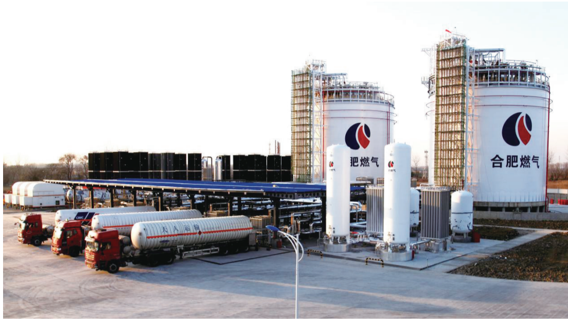
冬季,罗集门站开展LNG卸车作业,保障全市天然气安全稳定供应。
