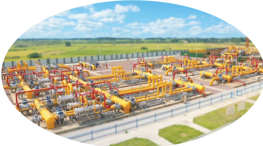
六安天然气高压管线通气运行实现气通金寨,助力革命老区建设。合燃华润燃气供图
