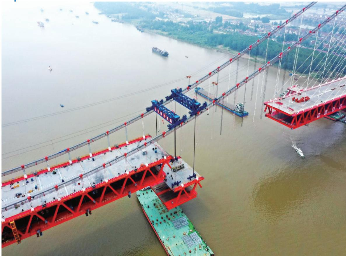
6月7日,中铁大桥局施工人员运用缆载吊机在G3(京台高速)铜陵长江公铁大桥建设现场架设中跨钢梁。
