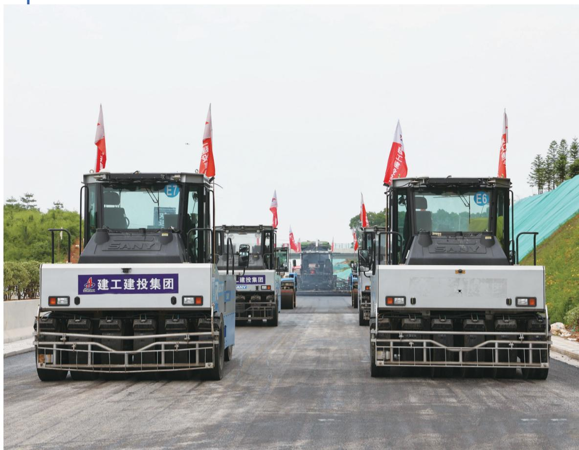
6月3日上午,在宣泾高速公路,无人摊压技术首次规模化应用,摊铺机、压路机在无人驾驶情况下,顺利完成沥青路面铺设和碾压。宣泾高速也成为我省首条无人摊压施工面层的高速公路。
