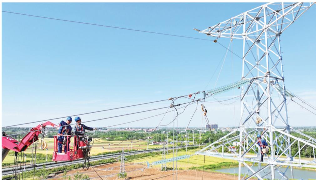
5月20日,在滁州市来安县半塔镇,电力工人正在对220千伏鹭贺4V80输电线路进行杆塔升高迁改施工作业。近年来,当地电力部门持续对区域电网进行升级改造,建设安全可靠、节能环保、技术先进、管理规范的新型供电体系,以适应用电快速增长的需要,为县域经济社会发展提供电力保障。
