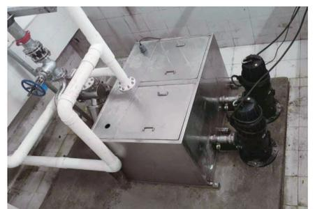
公司生产的高科技产品:固液分离型密闭式污水提升装置。
