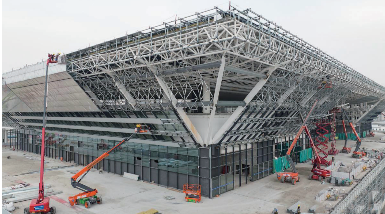
1月14日,在合肥市新合肥西站项目建设现场,工人正在抓紧施工作业。目前,新合肥西站站房主体已经完成、西广场及地下配套停车场工程实现主体结构封顶。 赵明 摄
