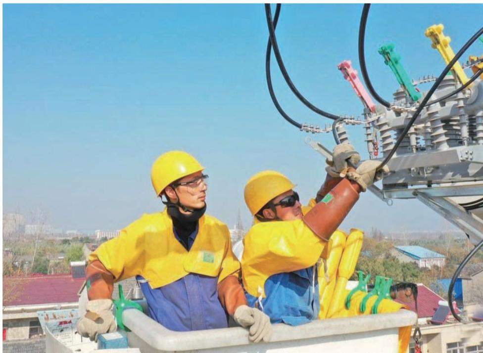
12月5日,在滁州市南谯区乌衣镇黄圩村,电力工人正在对10千伏黄圩116线路29号杆带电搭接柱上智能开关上引流线作业,保障当地企业和居民用电。为保证冬季各行各业的正常供电,滁州市供电公司优化提升供电服务,避免因断电施工给企业及居民生产生活用电带来不便,组织开展带电作业,以增加供电量,减少供电损失,确保城乡企业和居民生产生活用电安全。
