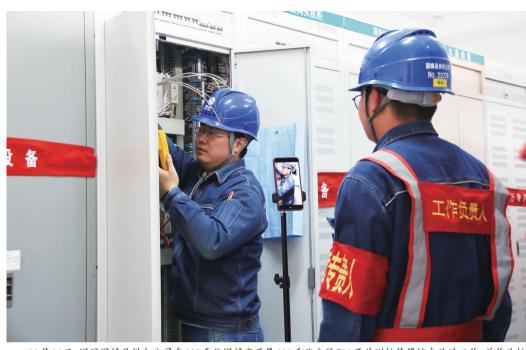
11月14日,国网固镇县供电公司在110千伏固镇变开展110千伏分段700开关测控装置综自改造工作,并作为核 心业务"自己干"典型案例进行全省视频直播观摩。此次综自改造项目是蚌埠市四县公司自110千伏变电站移交以 来,首次由县公司自主实施的110千伏设备综自改造项目,计划完成对110千伏固镇变电站全站监控和自动化设备的 更新,并解决110千伏和35千伏综保设备运行超年限的问题,提高固镇县城区供电可靠性。 吴昊宇 陈梦月摄
