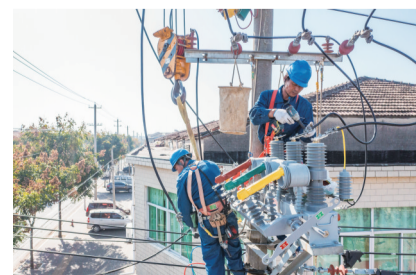
电力施工人员为智能联络开关进行接线。
