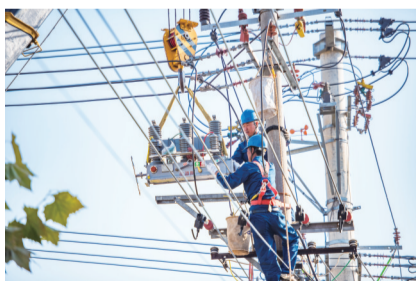
电力施工人员安装智能联络开关。
