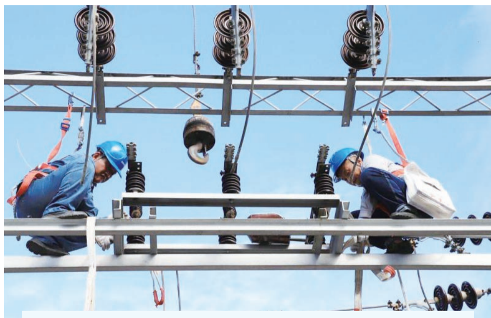
9月21日,国网涡阳县供电公司变电检修人员正在对35千伏高炉变电站进行检修消缺。入秋以来,国网涡阳县供电公司组织工作人员开展电网秋季安全检修工作,及时对电网设备进行检修消缺,提升电网健康水平,全力保障秋季农业生产和居民生活用电安全。 蒯延旭 摄
