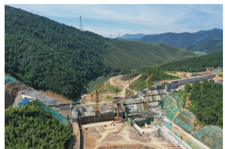
项目施工现场。
